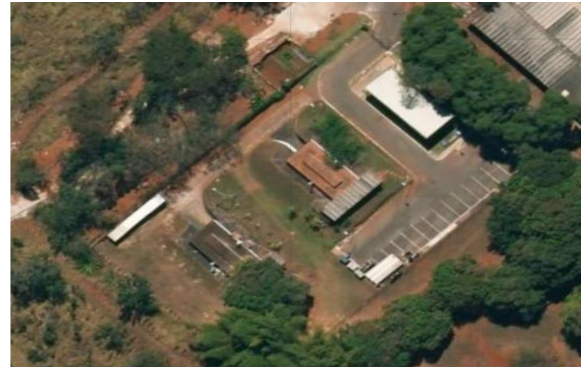
Imagem 2: Depósito Temporário de Resíduos Perigosos, UnB. Fonte: GeoPortal DF
